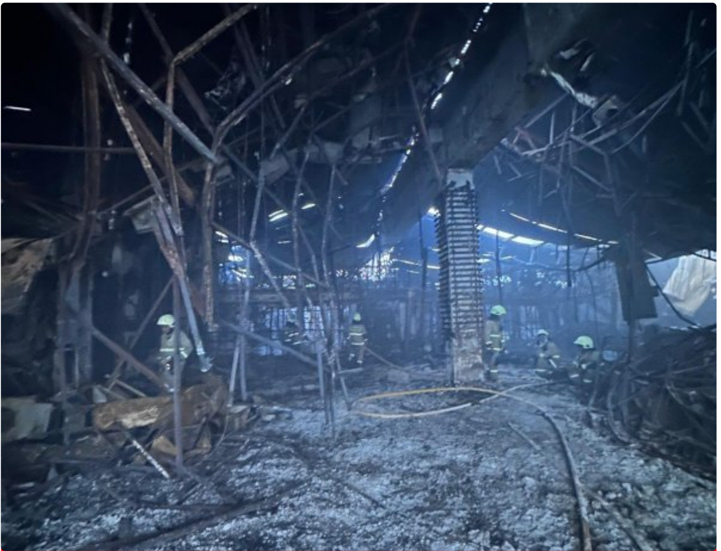
Glodok Plaza yang Hangus Terbakar
